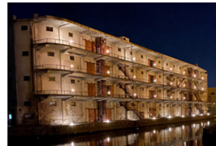
旧北海製罐小樽工場第3倉庫
