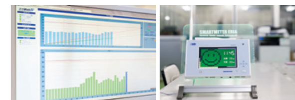
一部事業所で独自に消費電力の見える化を実施。 左:北海製罐(株)中央研究所 右:オーエスマシナリー(株)小樽工場
